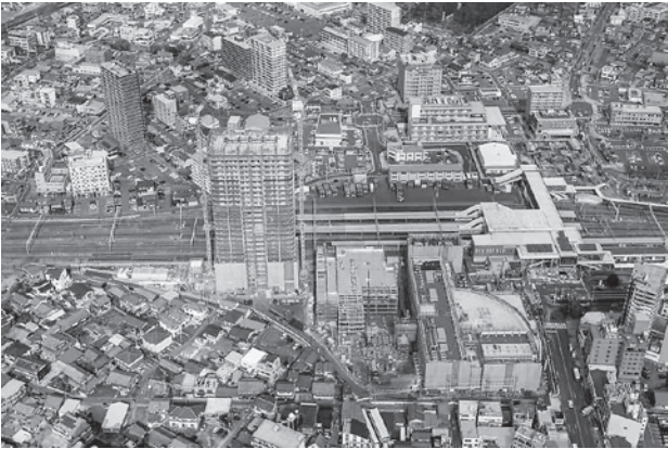
整備が進む多治見駅南地区
