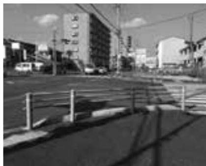
太平町地内の交差点に設置されたガードパイプ (三輪寿子撮影)
