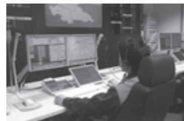
高機能消防指令システム
