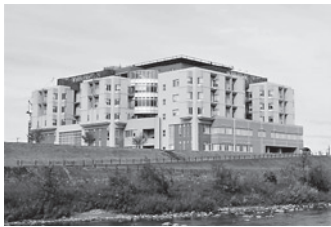
多治見市民病院 外観
