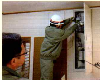
▲ 漏電等の点検 (中部電力)
