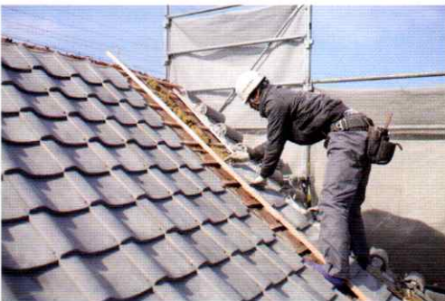
▲ 屋根瓦の葺き替え
