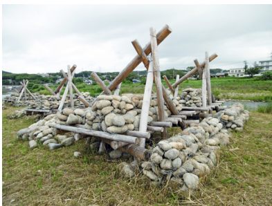
▲土岐市にある伝統治水工法「聖牛」 川の流れを弱め、堤防の決壊を防ぐ。
