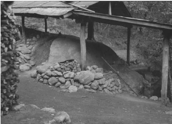
牟田洞の荒川豊蔵の穴窯 写真提供 (財) 豊蔵資料館
