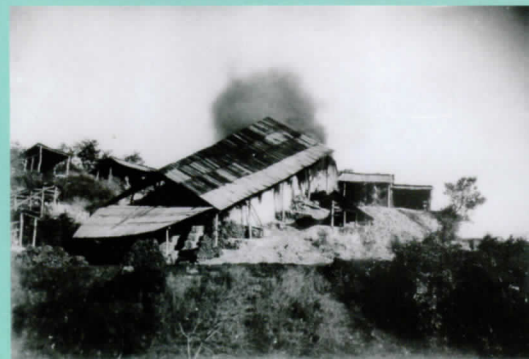
多治見尾張坂に作られた西浦の登り窯 (写真提供 多治見市図書館郷土資料室)
