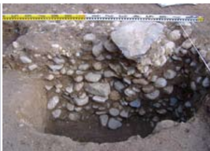
濃尾震災後に再建された本堂の基礎
