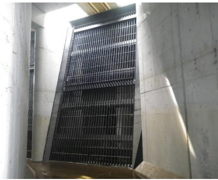
池田下水処理場 合流系沈砂池設備
