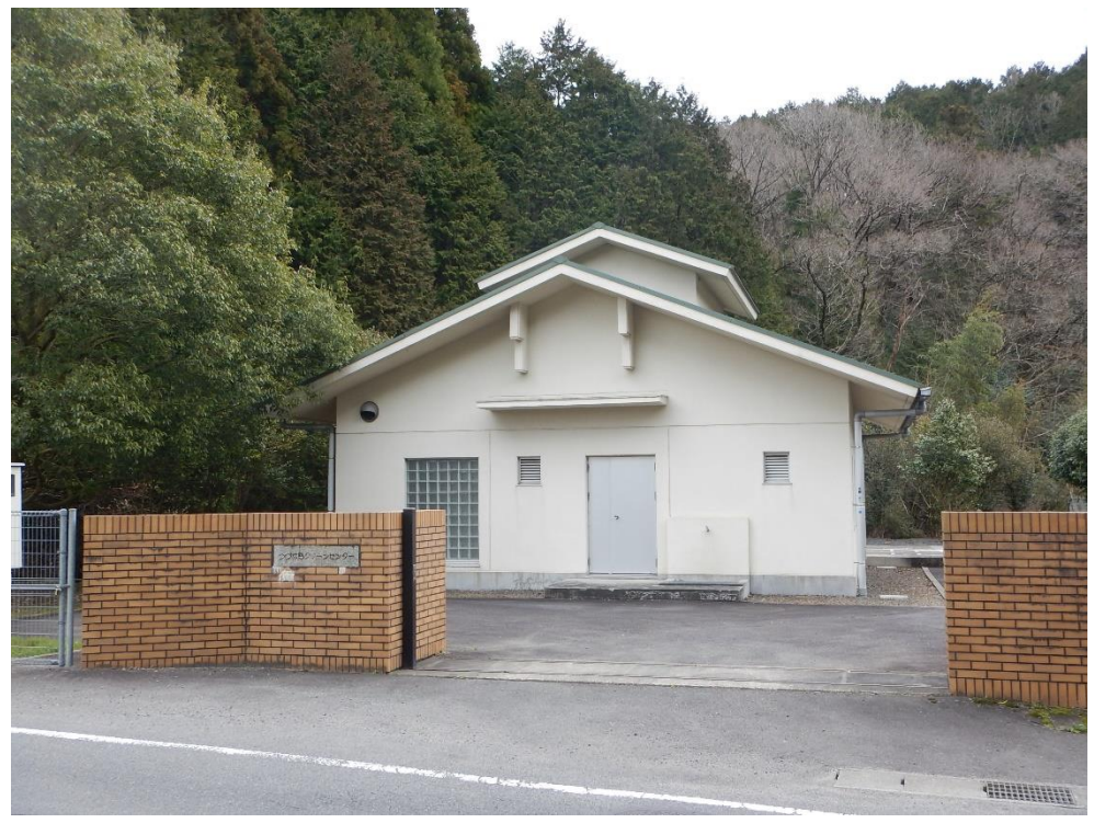
甘原クリーンセンター
