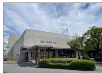
パロー文化ホールの大規模改修
