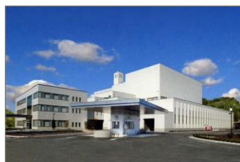
三の倉センターの大規模修繕
