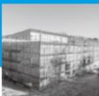
建設中の食育センター
