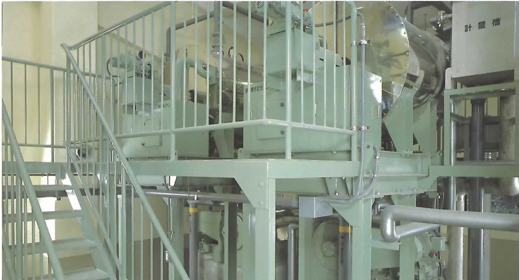
●前処理設備 し尿に混じっている布・紙・ビニールなどは破砕機で細かく切断し、細目スクリーンとスクリープレスで分離・脱水します。
