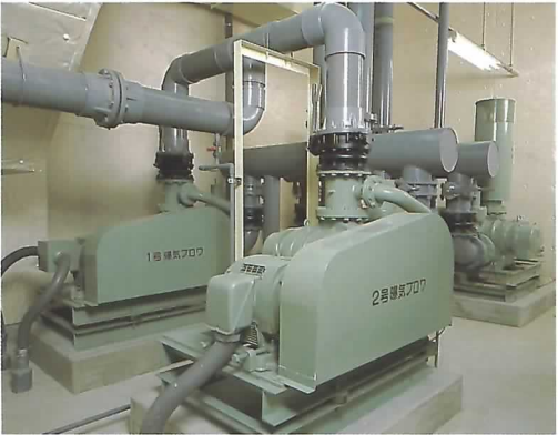
●曝気プロフ 微生物が活発に繁殖できるよう、汚水中に空気を送り込む装置です。
