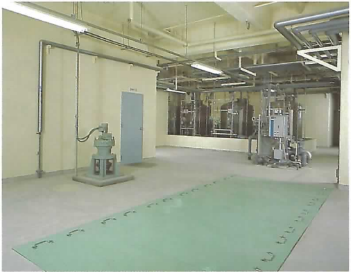
●沈殿槽 生物処理水を静置して、汚泥を沈殿分離し、きれいになった上澄水を下水へ放流します。
