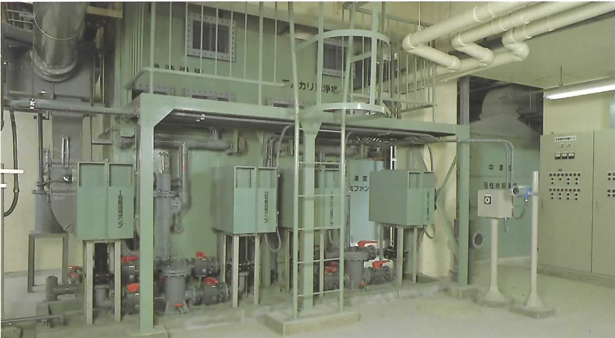
●高濃度臭気脱臭設備 受入・貯留槽や前処理機械などで発生する高濃度臭気は、曝気プロフに導き、曝気槽で生物脱臭処理します。
