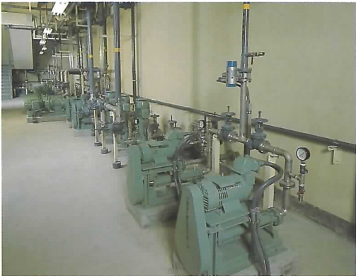
●地下ポンプ室 受入れたし尿や浄化槽汚泥に含まれている紙や布・ビニールなどを破砕機で細かく切断します。また、前処理分離液を定量的にポンプで圧送します。
