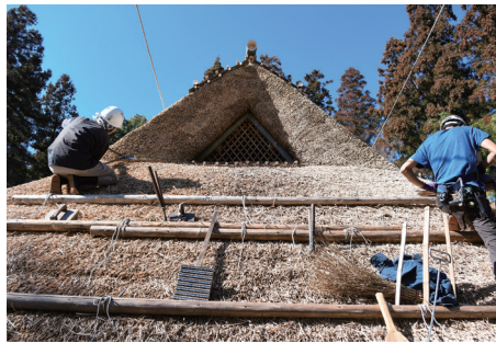
写真（上下）永保寺五峰庵屋根葺き替えの様子
