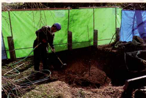
▲エアスコップでの掘削
