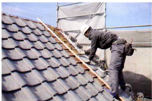
▲ 屋根瓦の葺き替え
