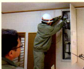
▲漏電等の点検（中部電力）
