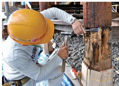
▲柱の蟻害部分の補修
