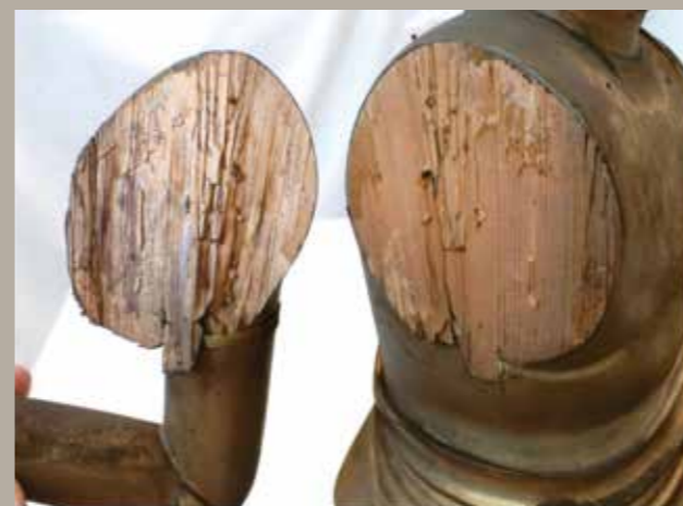
【写真①】 右肩接合面の調査
