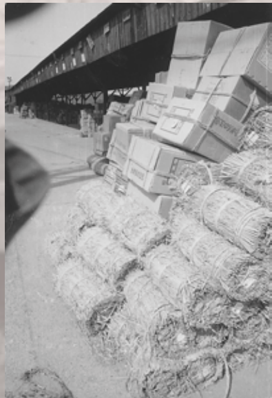
▲荷造りされた陶磁器が積まれた多治見駅の集積場(昭和40年頃) (写真提供:多治見市図書館郷土資料室)
