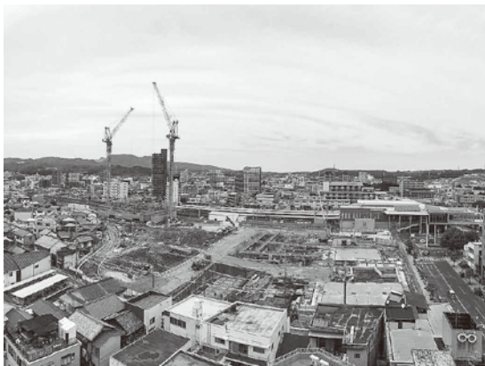
整備が進む多治見駅南地区
