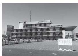
本庁舎建設予定地
