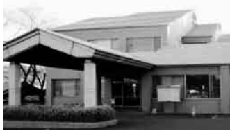
かさはら福祉センター外観
