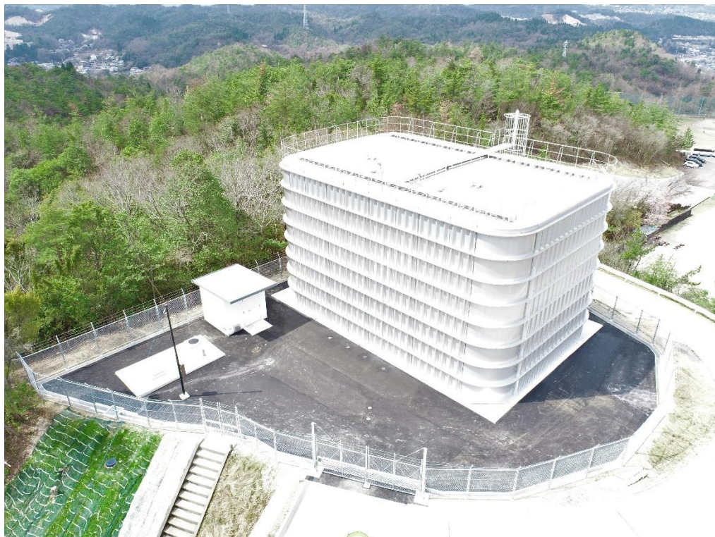
滝呂台配水池 令和3年2月完成
