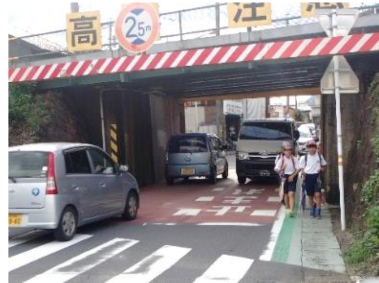
旧保健センター跡地前の高架下
