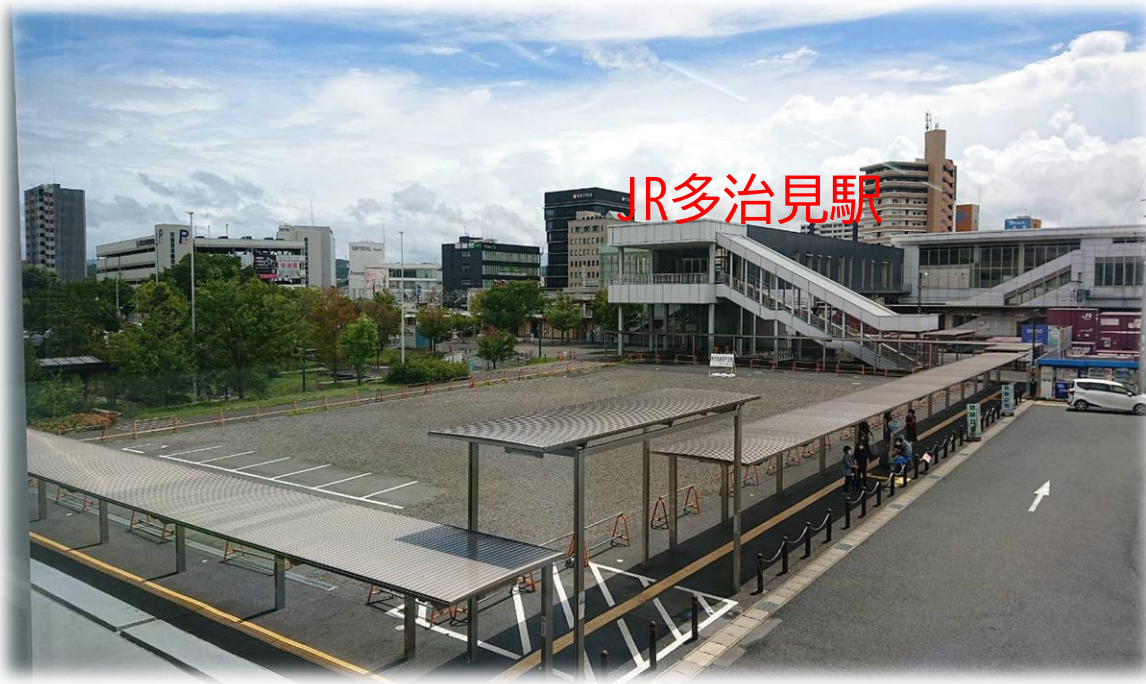
JR多治見駅北口 本庁舎建設予定地
