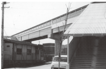
昭和後期の駅北側出口。コンコースを通って駅の北側へ出ると、階段横に迎える車が並んでいた。
