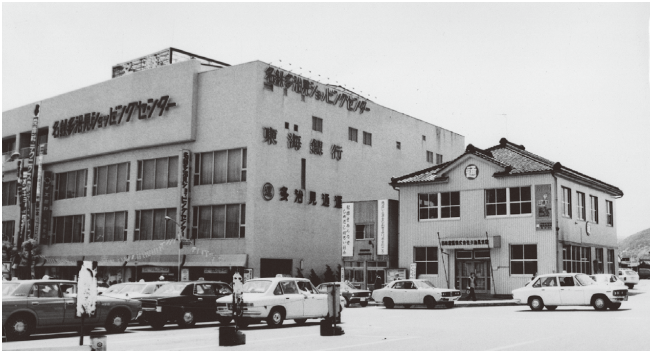
多治見駅前通りに建てられた名鉄多治見ショッピングセンター。立ち退いた小規模店の一部はテナントとなった。多治見通運、東海銀行(現三菱UFJ銀行)の文字がみえる。昭和40年代後半。
