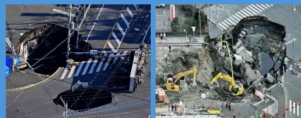
(八潮市の陥没事故: 令和7年1月28日)
