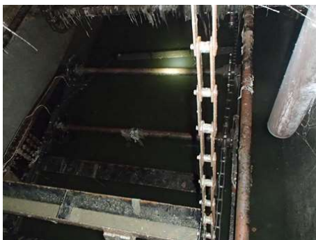
① 揚砂装置の故障(池田)
