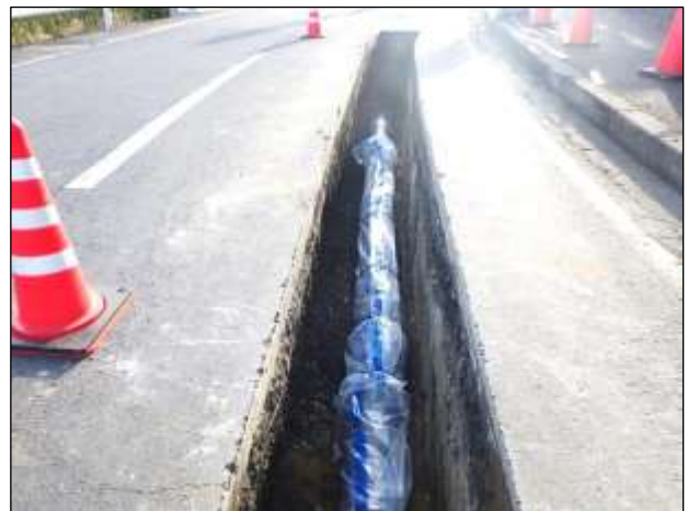
図表 [4]-2-2 送・配水管耐震化工事の様子
