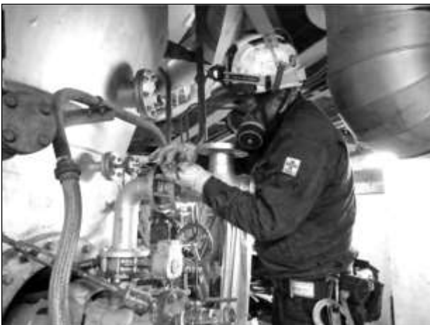
図表 [4]-5-2 基幹改良長寿命化工事の様子
