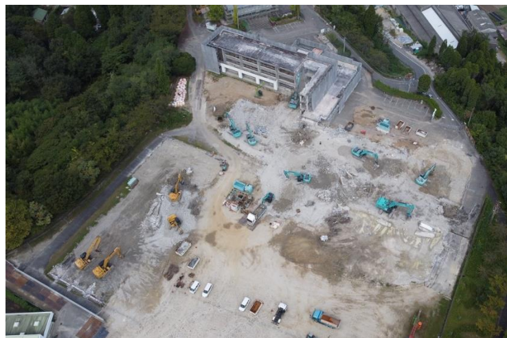
解体工事(笠原小学校内)
