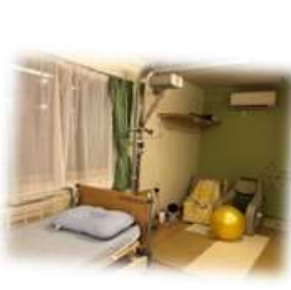
介護用リフト・ベッド設置
