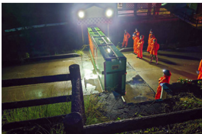
勝山陸閘の閉鎖作業（坂祝町）
