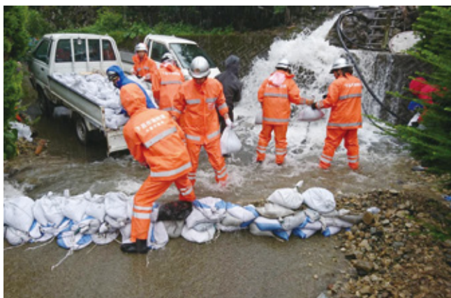
道路や民家への浸水を防ぐ土のう積み（下呂市）
