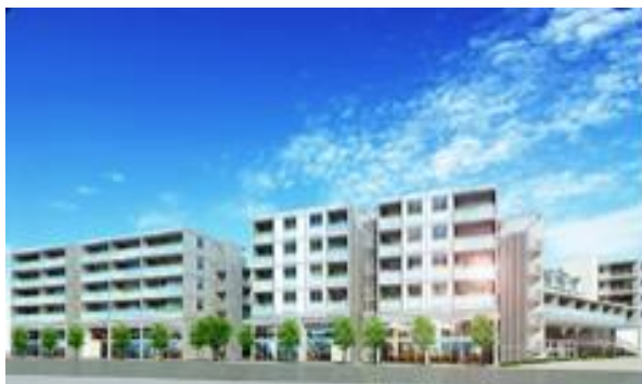
石巻市中央三丁目地区／市街地再開発事業（宮城県）
