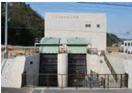
整備された土岐川左岸ポンプ場
