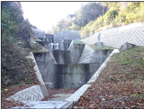
砂防えん堤の整備（月見町）
