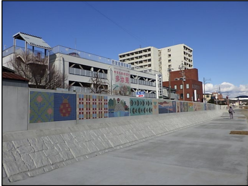
土岐川の堤防整備
