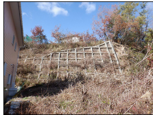
急傾斜地崩壊対策工事（小泉地区）
