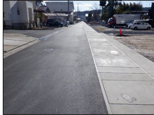
排水路整備（喜多町）
