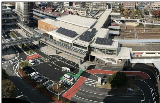
多治見駅南駅前広場
