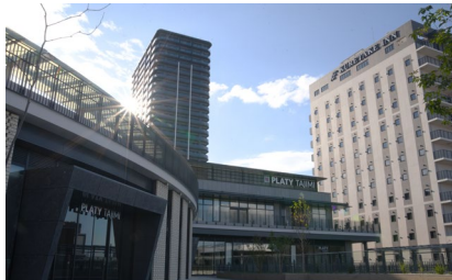
多治見駅南地区で市街地再開発事業が完了
