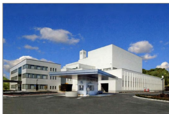
三の倉センターの大規模修繕
