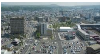
多治見駅北地区のまち並み
