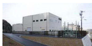
整備された土岐川左岸ポンプ場
