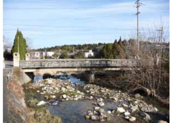
大坪橋：橋長 22.2m 架設年度 昭和 8 年
