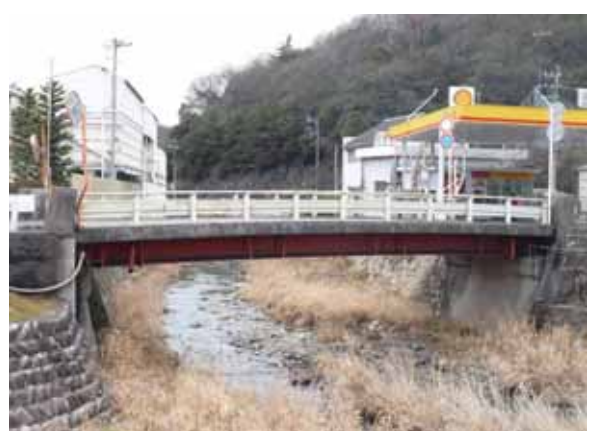
川尻橋：橋長 15.4m 架設年度 昭和 40 年
