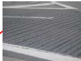
グルーピング舗装 ※流出する車両の存在を音で知らせる
