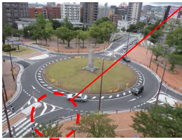
グルーピング舗装 ※流出する車両の存在を音で知らせる
