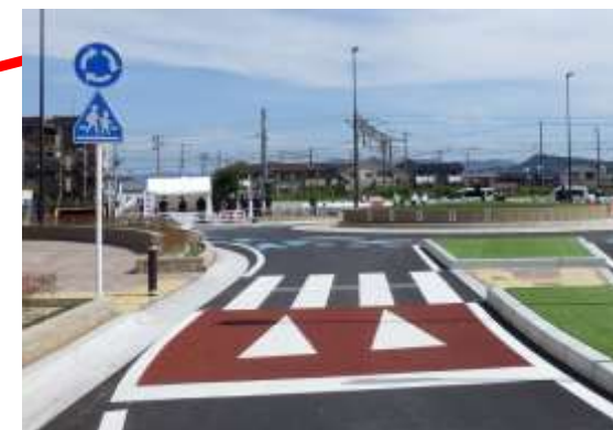
横断歩道の手前に ハンプ路面表示の施工
