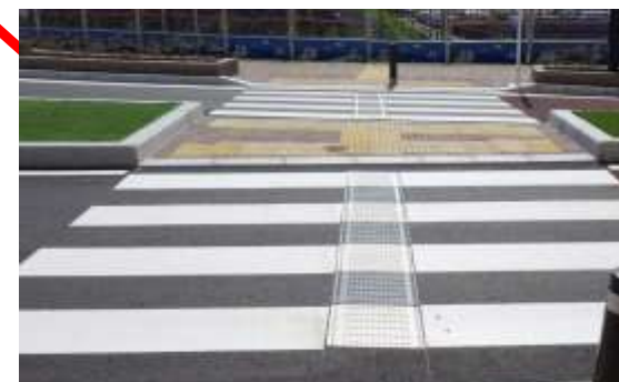
横断歩道の手前に ハンプ路面表示の施工
