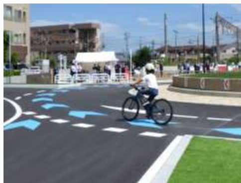
矢羽根型路面表示等の設置
