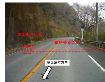
【(主)名古屋多治見線 排水対策】
