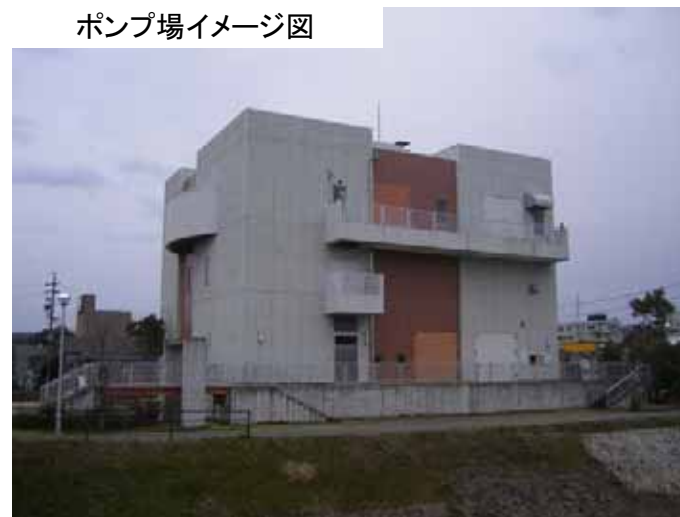
写真は 笠原川右岸ポンプ場
