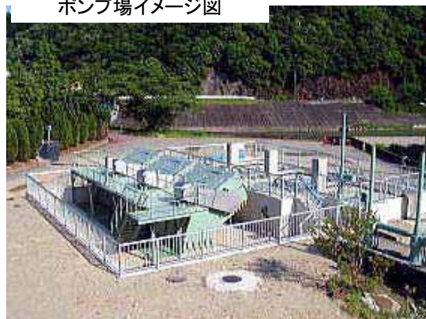
写真は 既設土岐川右岸ポンプ場
