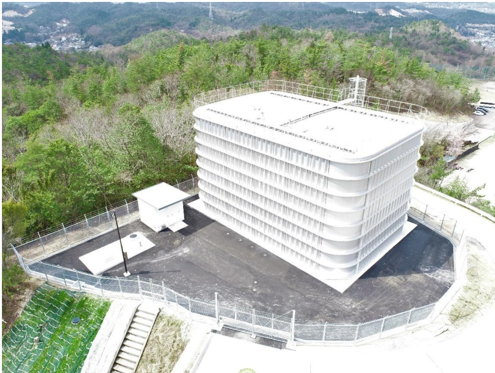
滝呂台配水池 令和 3 年 2 月完成
