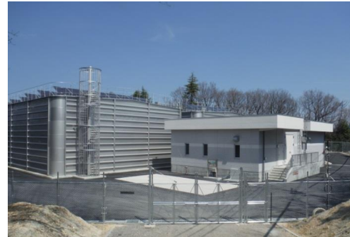
図5 虎溪山配水池
