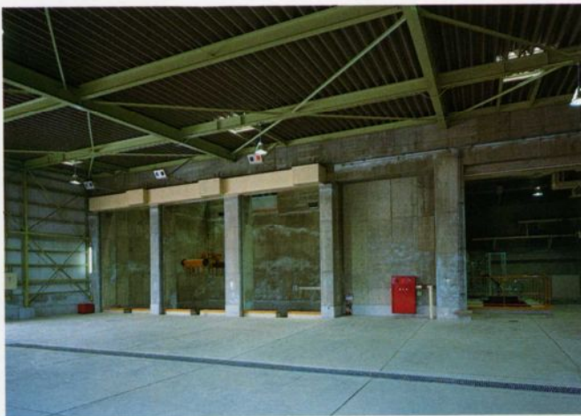
プラットホーム
