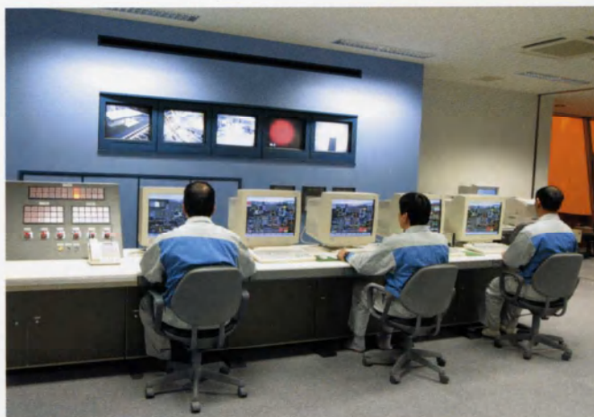
■中央制御室 本施設の頭脳ともいべき場所で各設備のデータをコンピュータにて 集約・管理しています。
