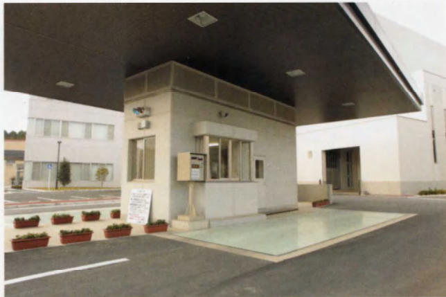
■計量機(トラックスケール) 収集されたごみを入場時に計量・記録し、集計管理します。
