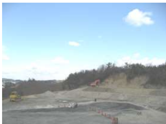
安定型最終処分場
