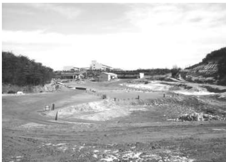
安定型最終処分場
