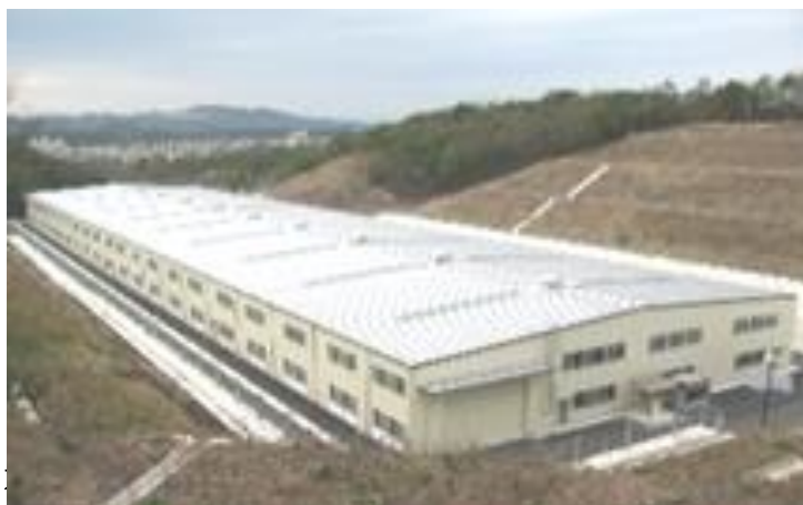
管理型（クローズド型）最終処分場
