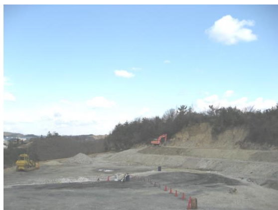
安定型最終処分場
