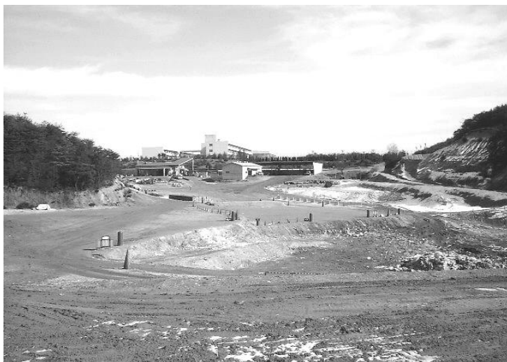
安定型最終処分場
