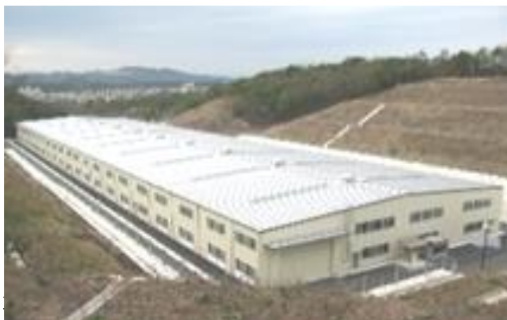
管理型（クローズド型）最終処分場
