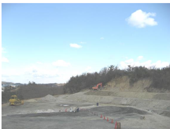
安定型最終処分場
