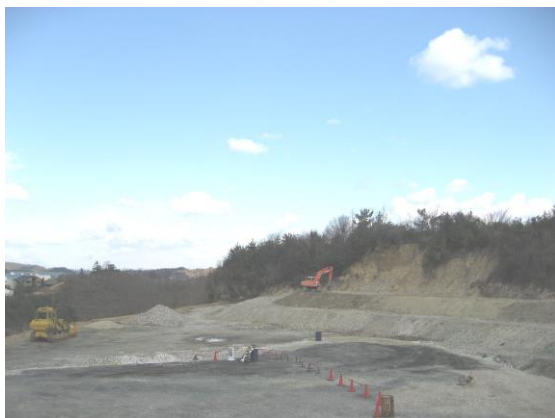
安定型最終処分場
