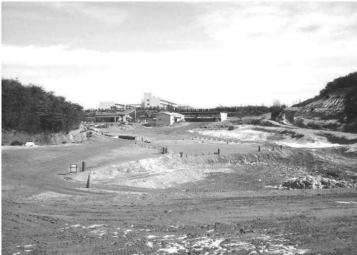
安定型最終処分場
