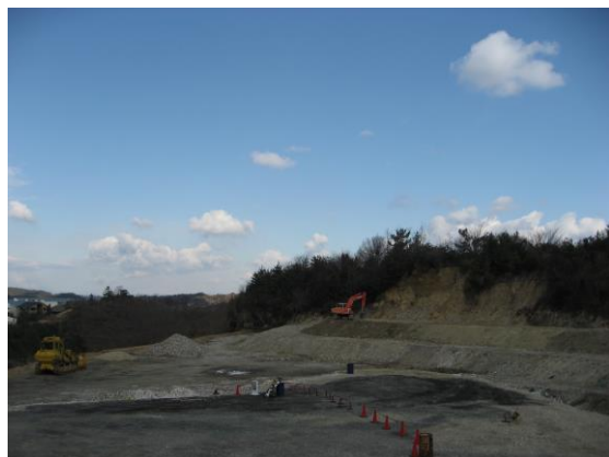
安定型最終処分場
